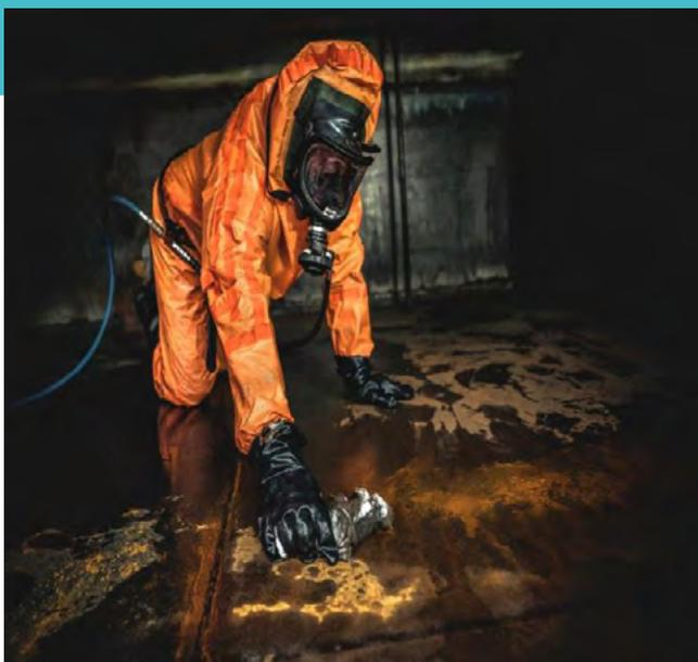
Nettoyage de la cuve d'un tanker
