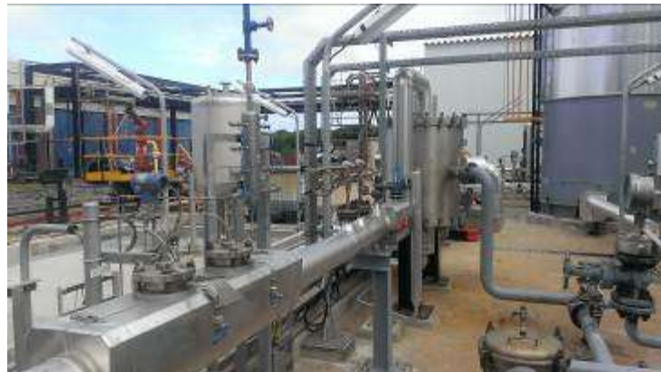
Système de chauffage et injection d'émulsifiants
