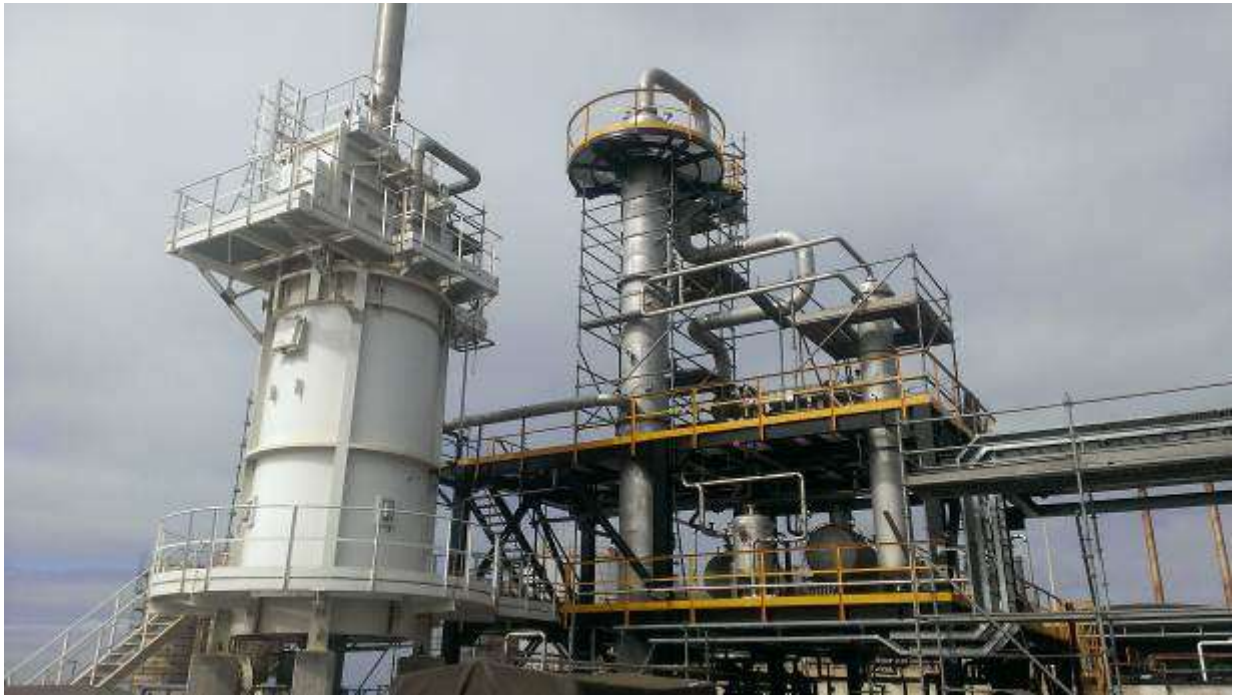
Vue large de l'unité de traitement P2R (four à gauche et colonne de distillation à droite)
