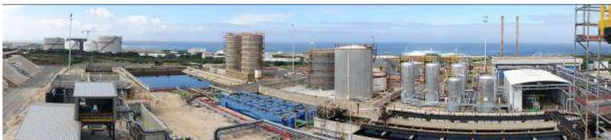
Vue des installations de l'Unité de Sines (octobre 2014)
