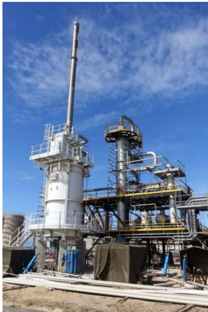
Vue large de l'unité de traitement P2R (four à gauche et colonne de distillation à droite)
