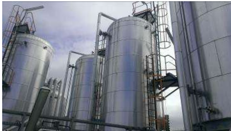
Système de chauffage et injection d'émulsifiants
